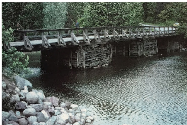
Hur bron såg ut 1956 och hur den i stort sett ut under hela 1900-talet.
